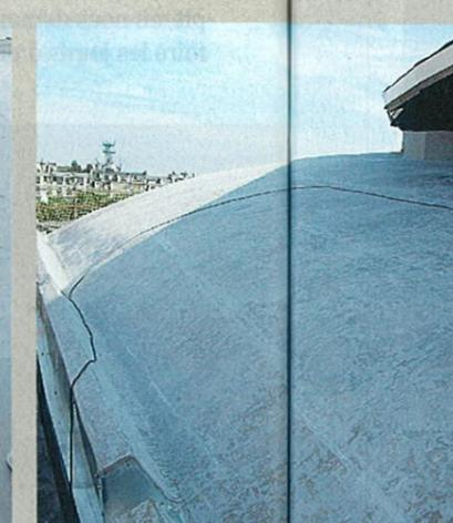
**4** Le recouvrement des lés est de 5 cm. Immédiatement après la mise en place de l'armature, une seconde passe de
