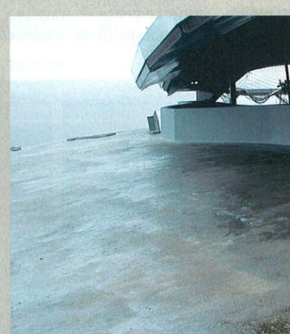
**2** Le primaire d'accrochage est mis en œuvre au rouleau sur l'ensemble de la surface. Le produit, composé de durcisseur et de catalyseur (trois composants en tout), a une durée pratique d'utilisation relativement courte.
