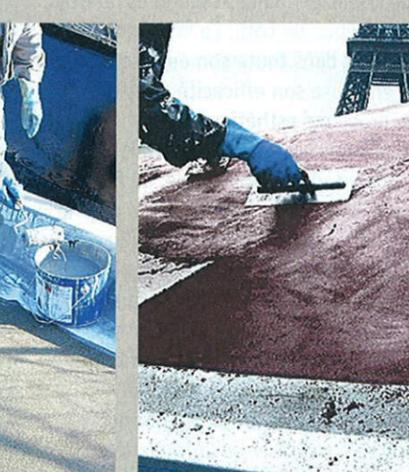
**5** Comme le reste de la couverture, l'ensemble des relevés est traité. Il s'agit d'assurer la continuité de l'étanchéité et de répondre aux exigences des normes NFP 84, série 200 (DTU 43.1 et 43.2).
