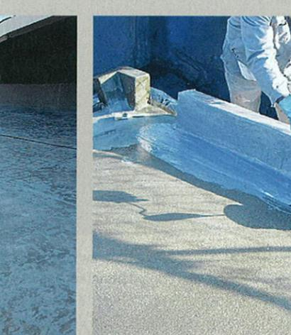
résine est appliquée (1 à 1,2 kg/m<sup>2</sup>). Il s'agit de parfaire l'enrobage et d'assurer une épaisseur minimale de 2 mm.
